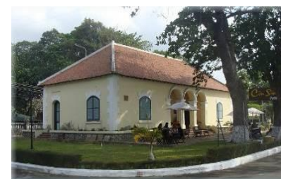
Nhà Công Quán
