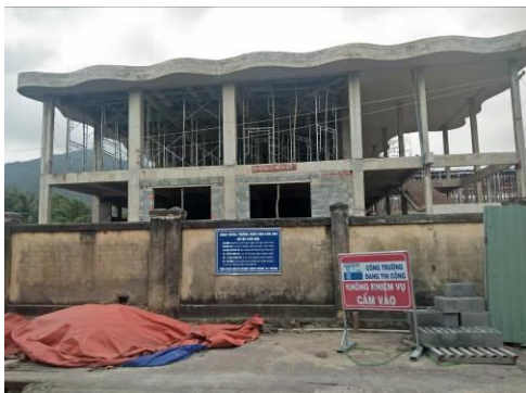
(Trường mầm non Côn Đảo đang xây dựng)
